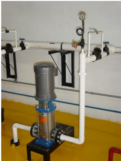
BOMBA DE 5 HP VERTICAL MULTITETAPA TANQUE PRECARGADO DE 40 GAL
