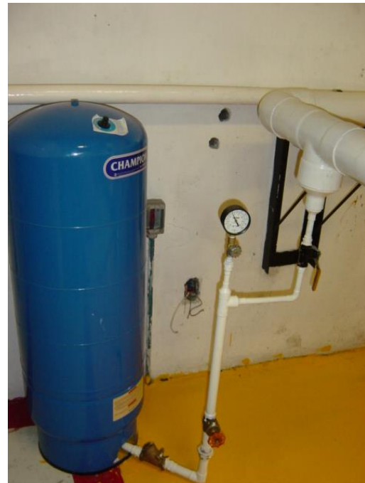
BOMBA DE 5 HP VERTICAL MULTITETAPA TANQUE PRECARGADO DE 40 GAL
